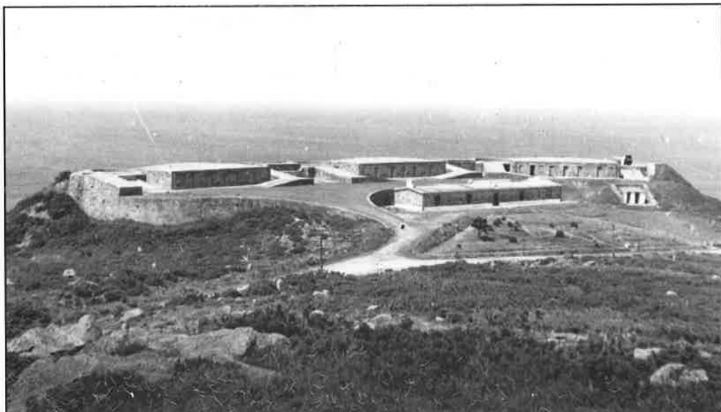
Bateria de Salgueira
