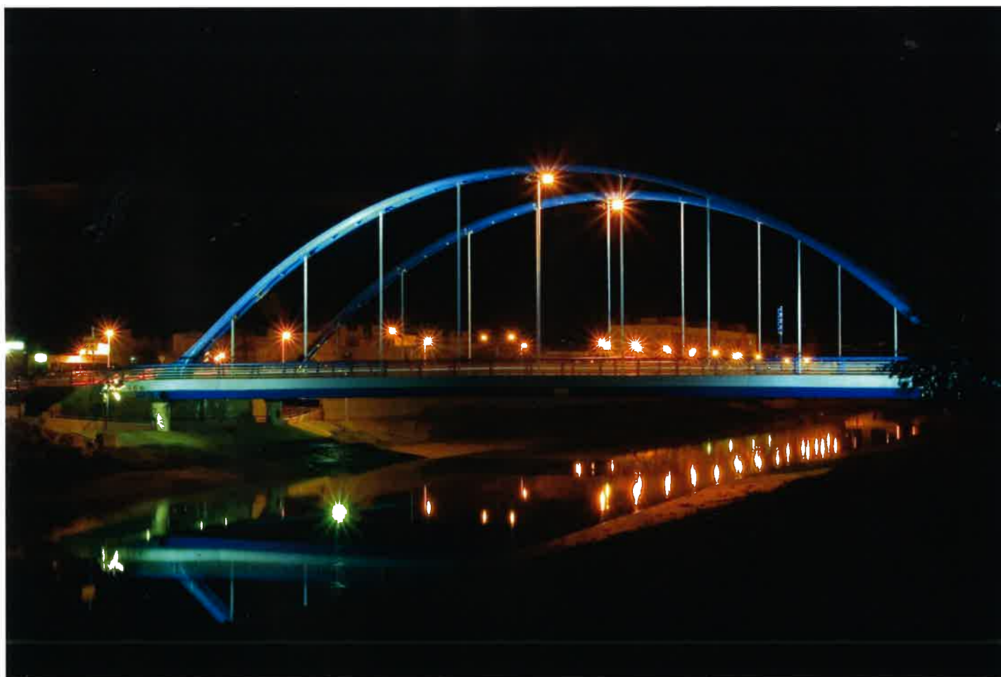
Vista del puente del centenario en Chiclana
