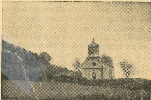
Vista general del Santuario de Chanteiro
